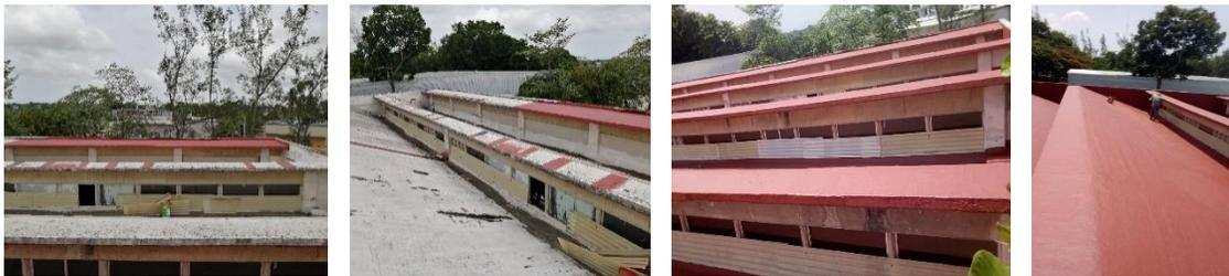
*Fig. 57 Impermeabilización de losa del edificio LIQP*
