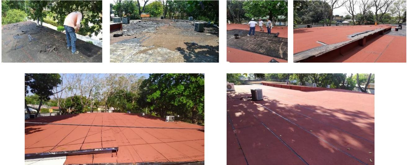
*Fig. 7. Impermeabilización del laboratorio de Ingeniería Industrial.*
