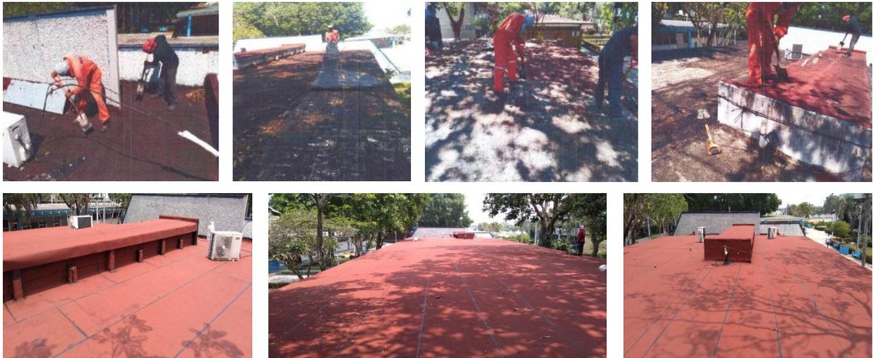
*FIG. 10. Impermeabilización del edificio D.*
