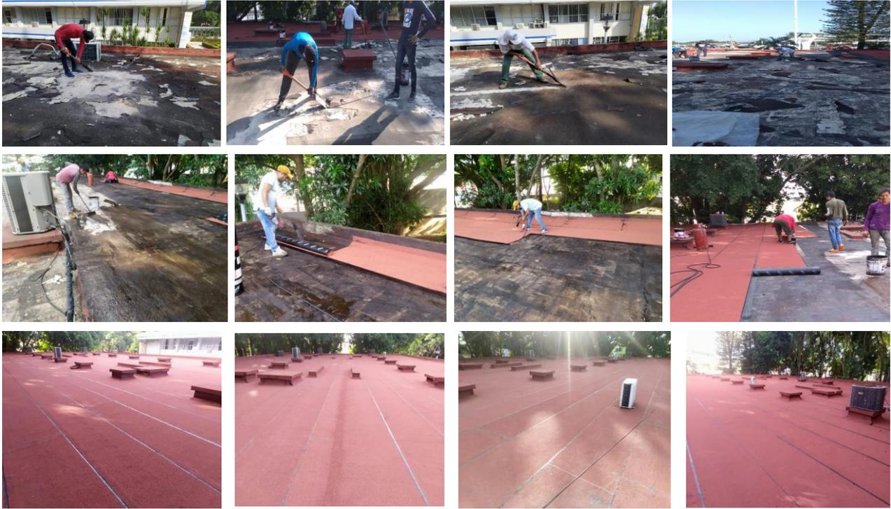
*Fig. 37. Impermeabilización del edificio ACA.*
