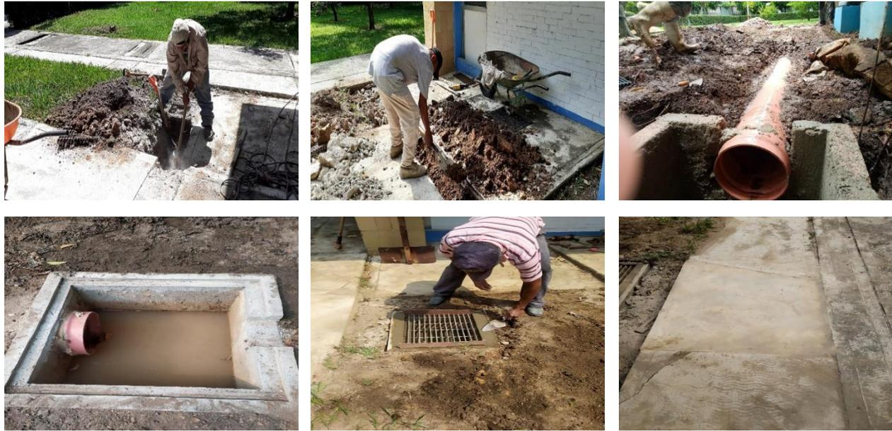
*Fig. 31. Construcción de desagüe pluvial parte trasera edificio G*
