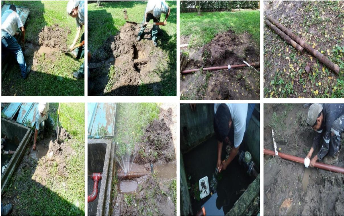
*Fig. 35. Mantenimiento a tubería en cárcamo de bombeo*
