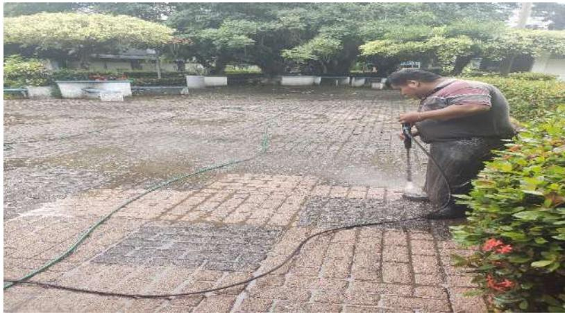
*Figura 81. Lavado de adoquines.*
