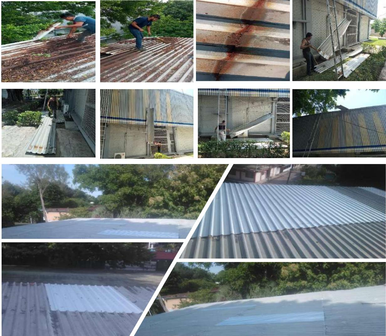
Figura 32. Mantenimiento a láminas de techo del edificio LIEM
