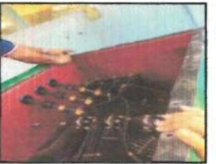
CAMBIO DE EMPAQUES DE BOQUILLAS DE BAJA Y MEDIA TENSION.
