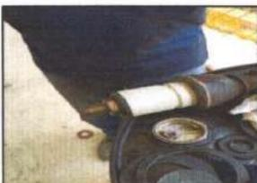
CAMBIO DE EMPAQUES DE BOQUILLAS DE BAJA Y MEDIA TENSION.
