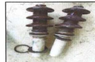
CAMBIO DE EMPAQUES DE BOQUILLAS DE BAJA Y MEDIA TENSION.
