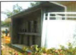
COLOCACION DE PUERTA DE ALUMINIO DE 2 HOJAS AL MURO DE PROTECCION DE LOS INTERRUPTORES DE MEDIA Y BAJA TENSION
