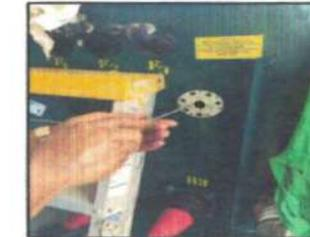
CAMBIO DE EMPAQUES DE BOQUILLAS DE BAJA Y MEDIA TENSION.
