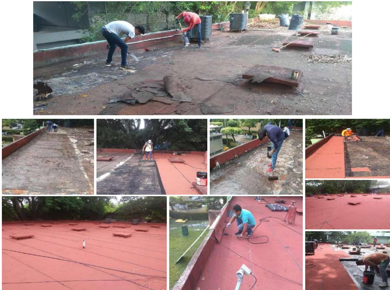
*Figura 30. Mantenimiento a losa de azotea del edificio M.*
