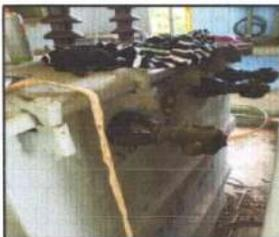
CAMBIO DE EMPAQUES DE BOQUILLAS DE BAJA Y MEDIA TENSION.
