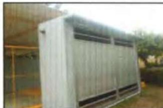
COLOCACION DE PUERTA DE ALUMINIO DE 2 HOJAS AL MURO DE PROTECCION DE LOS INTERRUPTORES DE MEDIA Y BAJA TENSION
