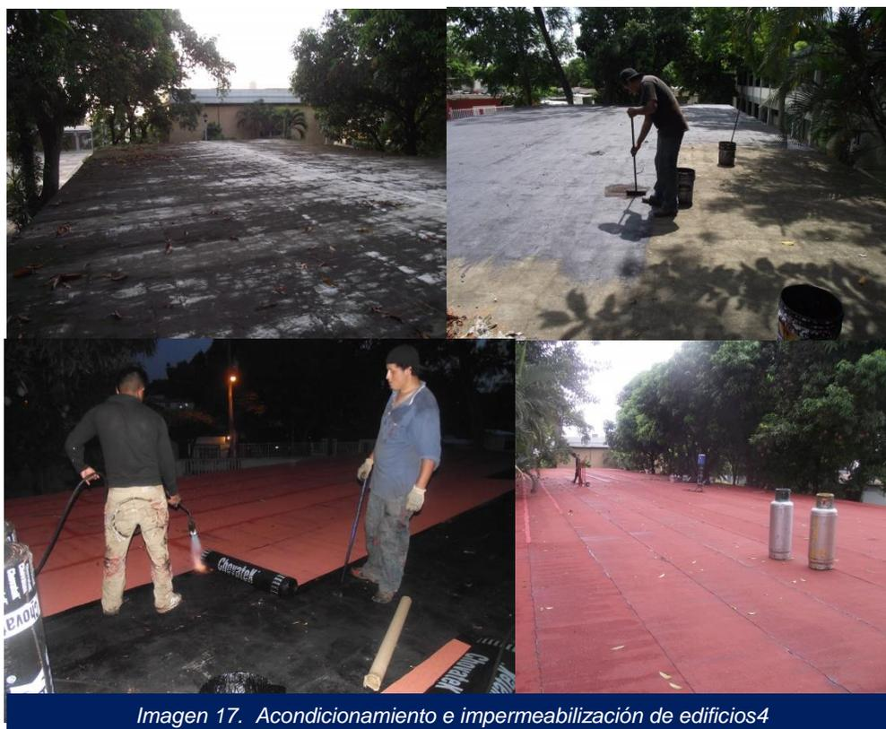
Imagen 17. Acondicionamiento e impermeabilización de edificios4
