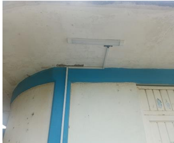
Figura 40. Instalación de Lámparas en la Bodega de Fútbol
