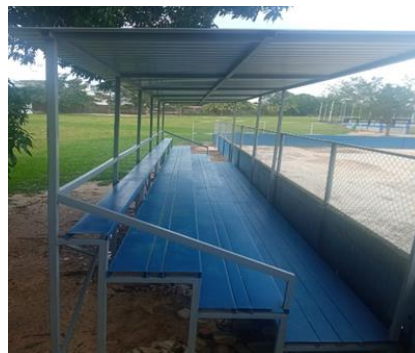
Figura 39. Instalación de Gradas en la cancha de Futbol Rápido
